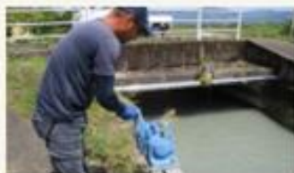
←水門を開けし、水を流しています。
